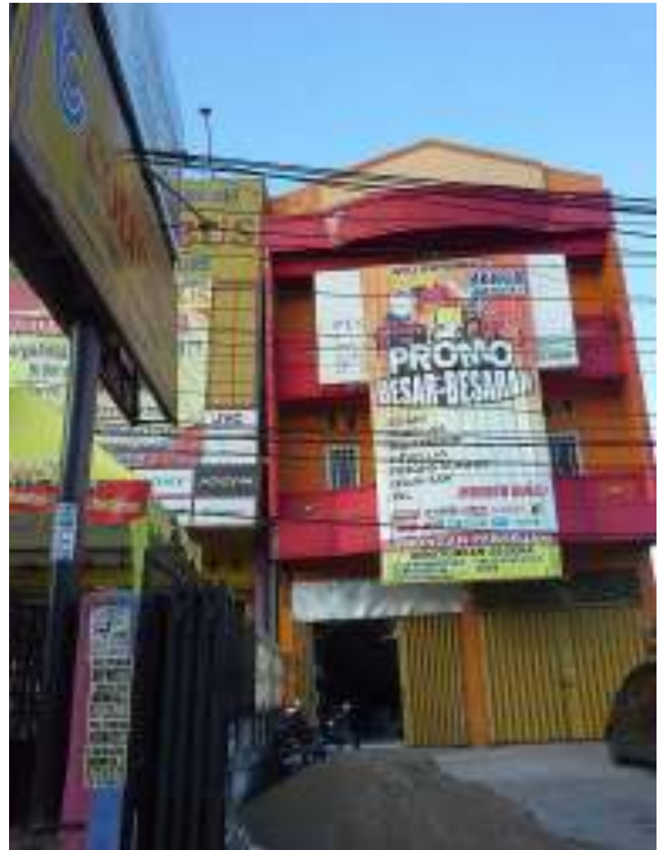
Indikator Subsidence : Bangunan Miring (Kota Banjarmasin, Kalsel. Foto @Suryadiputra, Juni 2014)
