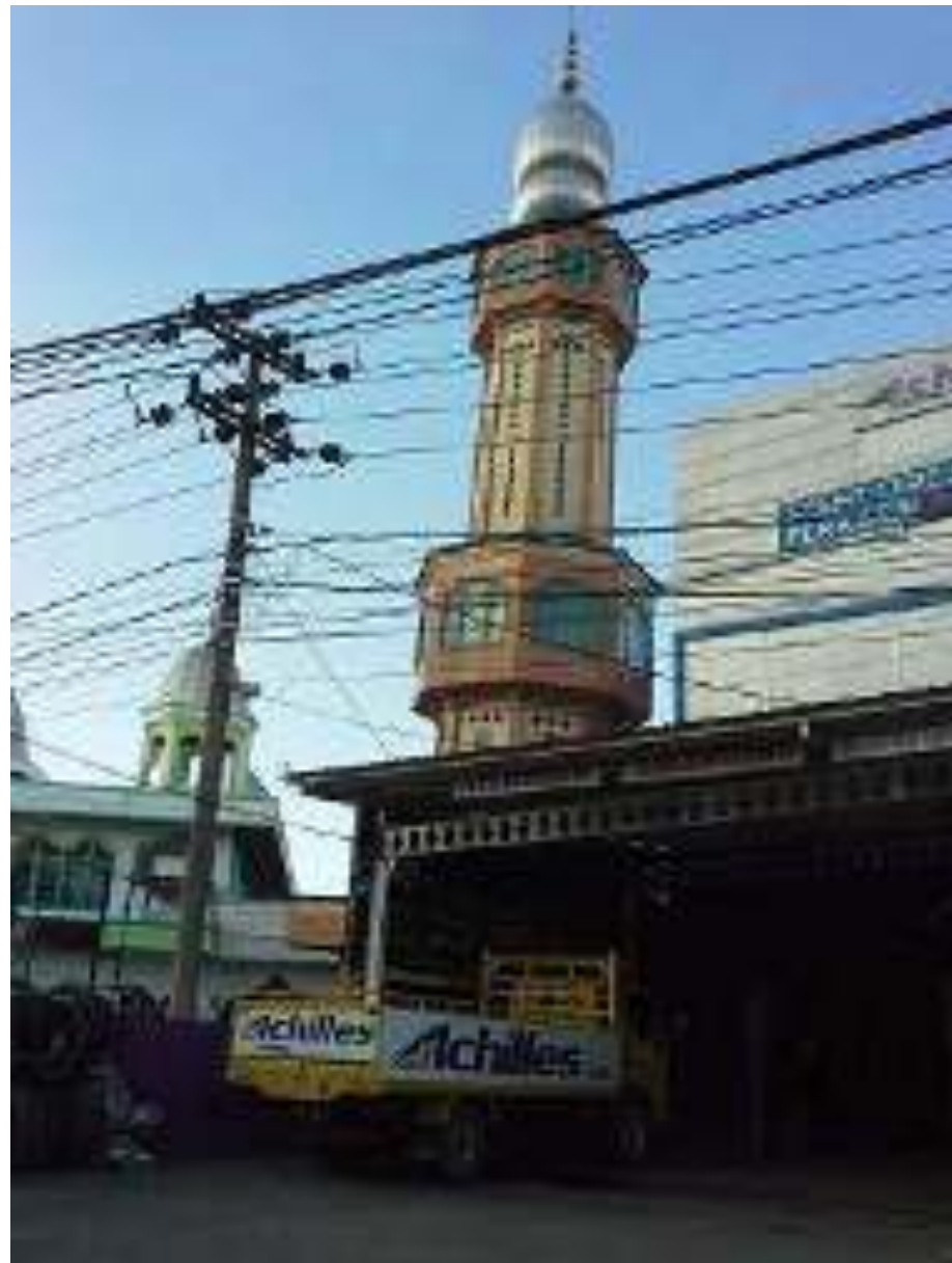
Indikator Subsidence : Bangunan Miring (Kota Banjarmasin, Kalsel. Foto @Suryadiputra, Juni 2014)
